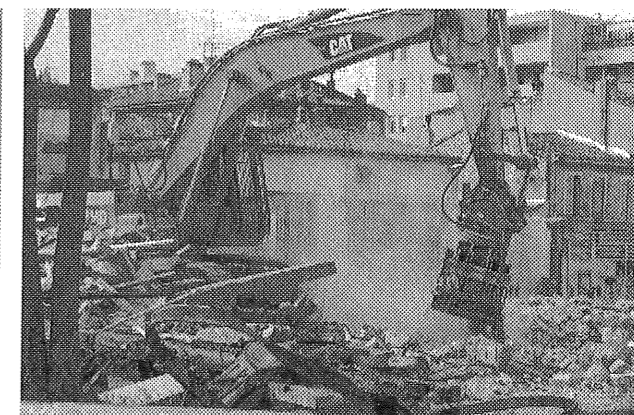
Démolition de l'ancien bâtiment militaire de l'îlot d'Eguison
