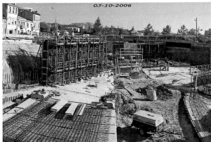
vue panoramique des travaux du Tunnel Louis Rège
