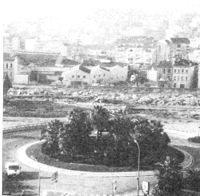
La démolition des hangars se poursuit.
