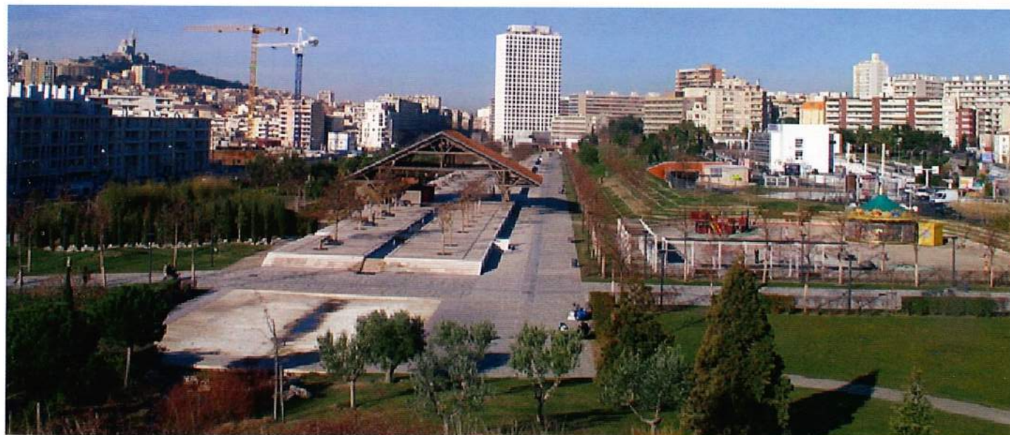
Le parc du XXVI ème Centenaire avant les travaux
