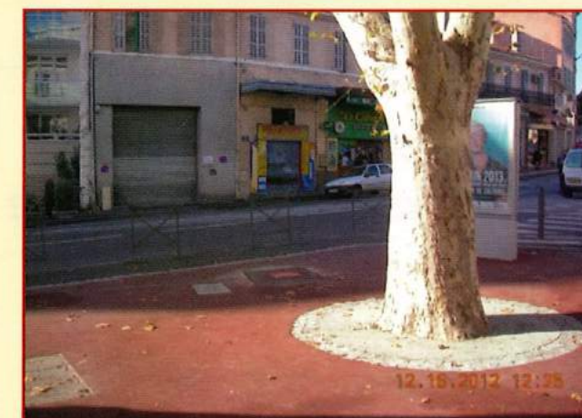
▲ La placette après les travaux.
