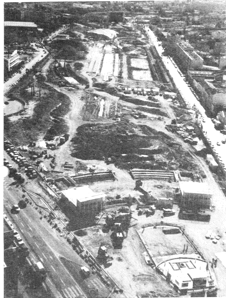
Vue d'ensemble des travaux du Parc du 26ème Centenaire avec ceux de la Fontaine de l'Arbre de l'Espérance (Octobre 2000)
